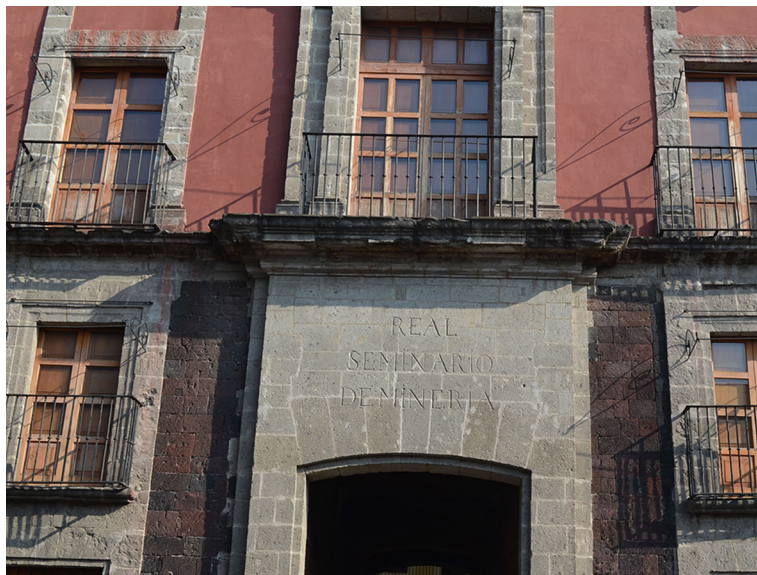
Real Seminario de Minería, ubicado en el centro de la Ciudad de México.
